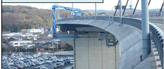
栄川運河橋 橋梁点検状況
