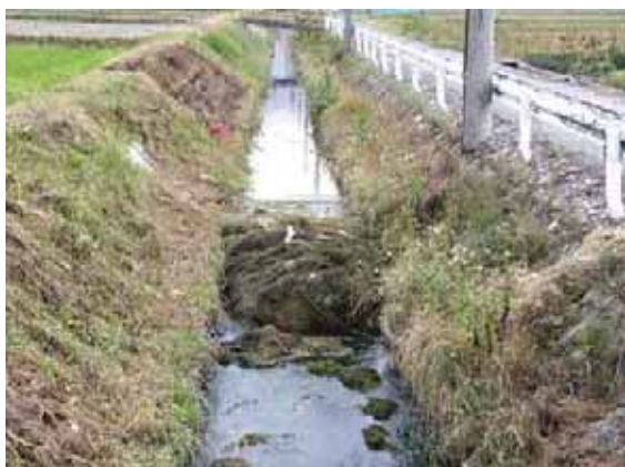
オオカナダモなどが詰まった排水路 写真提供: 姉川左岸土地改良区
