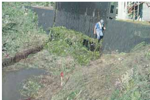
水草が詰まった除塵機 写真提供: 水茎干拓土地改良区
