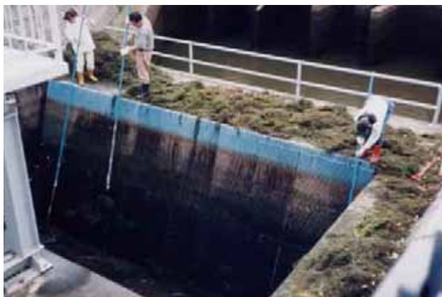
オオカナダモなどによる障害が起こった取水口 写真提供: 鴨川流域土地改良区
