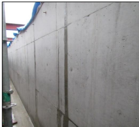
コンクリート表面状況
