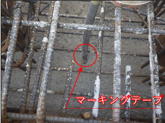
下層コンクリート 10cm程度挿入確認
