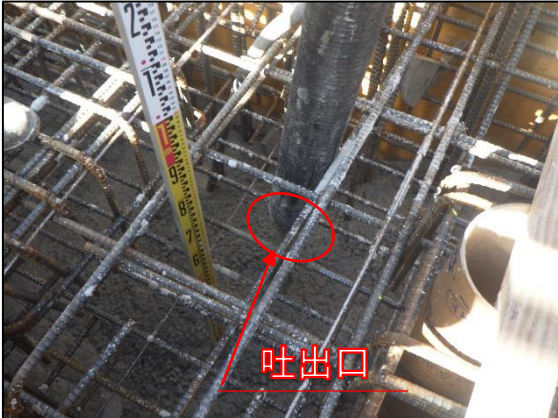
打込み面までの高さ確認 (1.5m以下)
