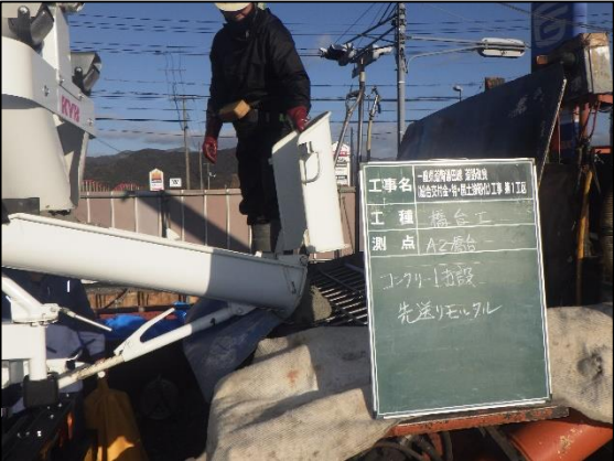
先送りモルタル確認
