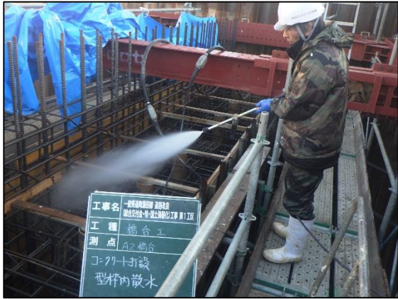
型枠面散水状況 (氷雪除去)
