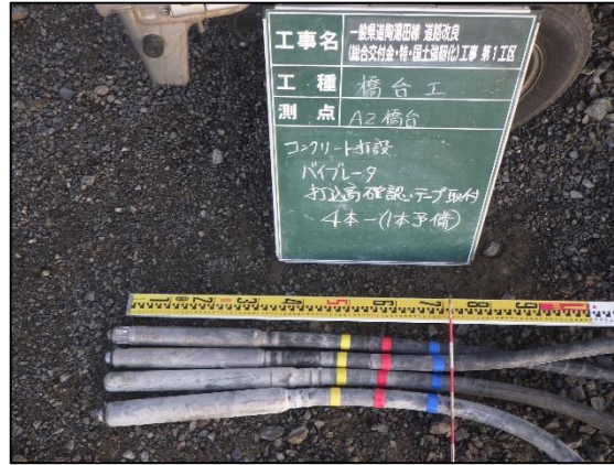
バイブレータ確認 (予備1本含む確認)
