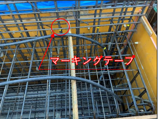
挿入間隔 型枠に50cm間隔テープ
