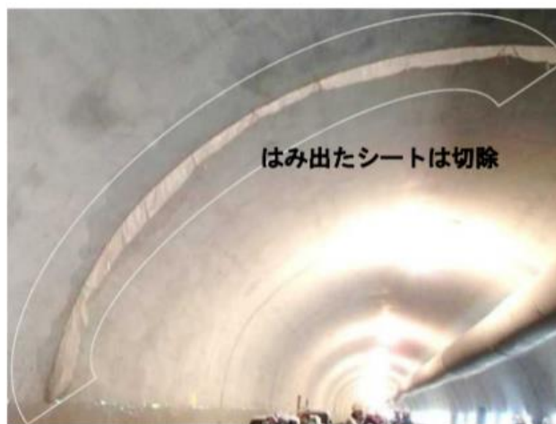
写真 6-14 施工目地へのピニールシート設置状況 (脱型後)
