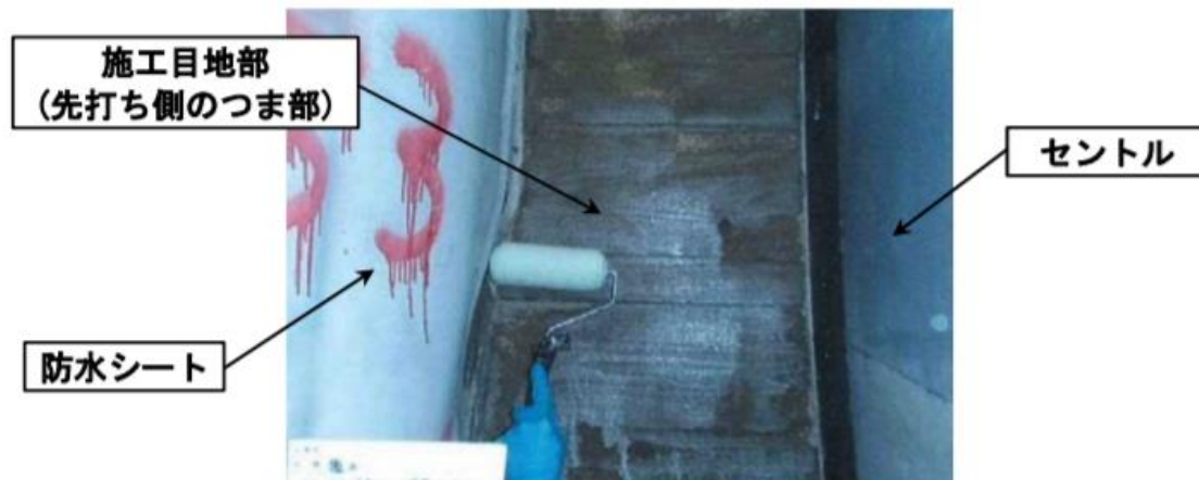
写真 6-19 目地部への付着を低減する材料の塗布例
