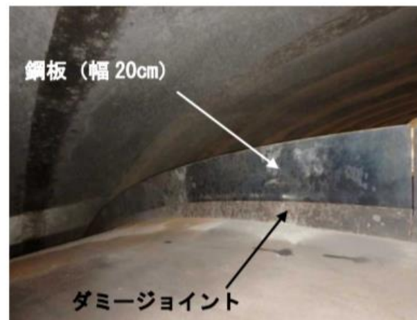
写真 6-17 目地部への鋼板設置状況 (移動式型枠内部より)
