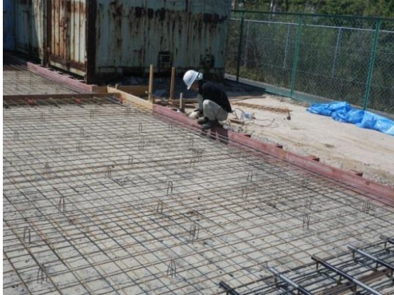
図 3-7-1 鉄網の設置状況
