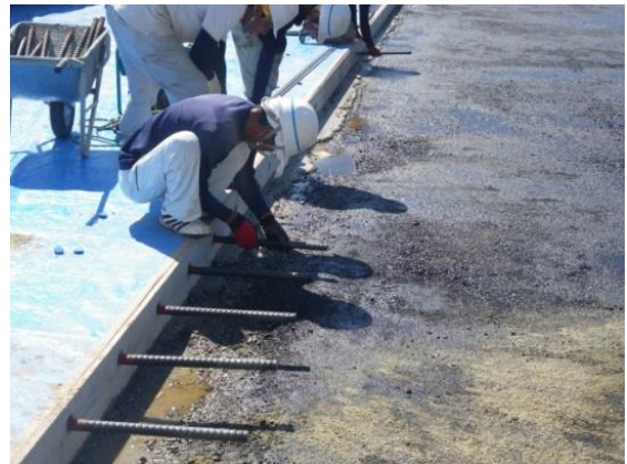
図 3-6-7 既設舗装への設置 (ねじ式)
