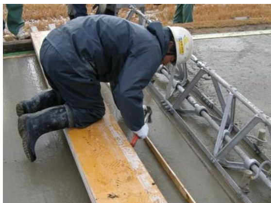
図 3-12-1 打込み目地の設置状況
