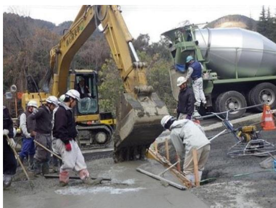
図 3-8-5 油圧ショベルによる荷卸し
