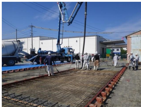
図 3-8-2 ポンプ車による荷卸し
