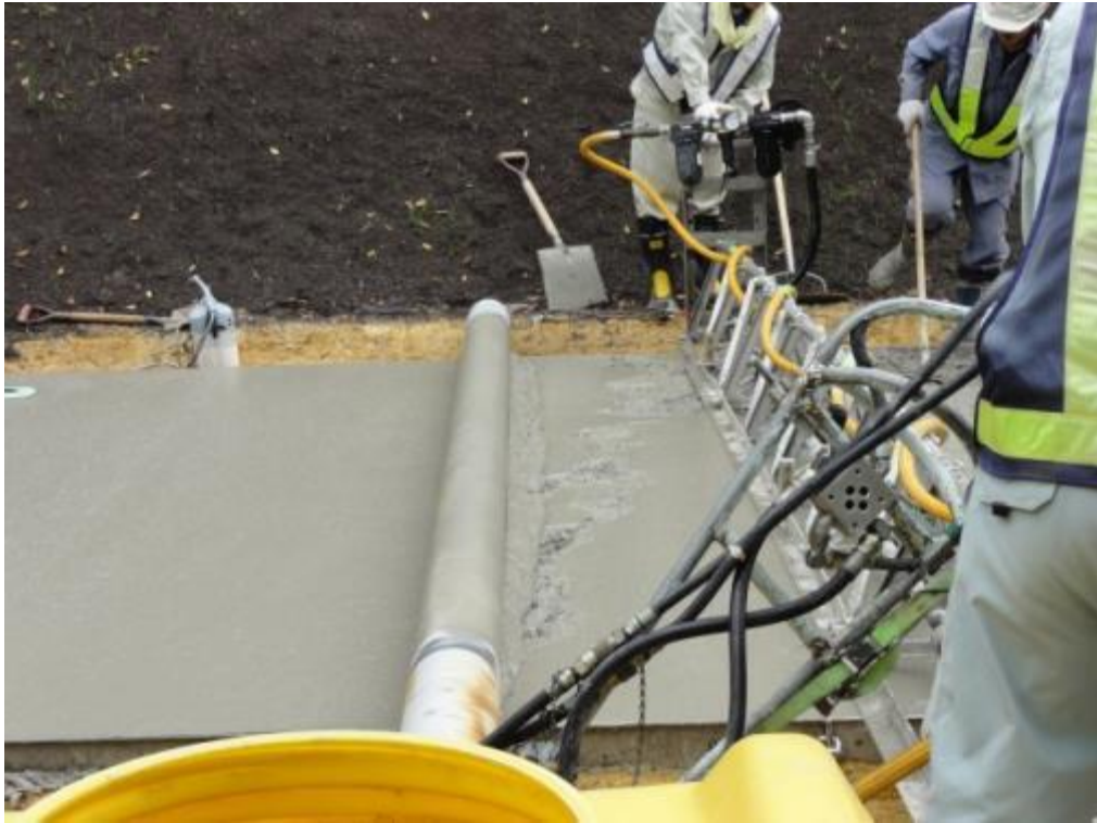
図 5-2-13 ローラーフィニッシャーによる仕上げの様子
