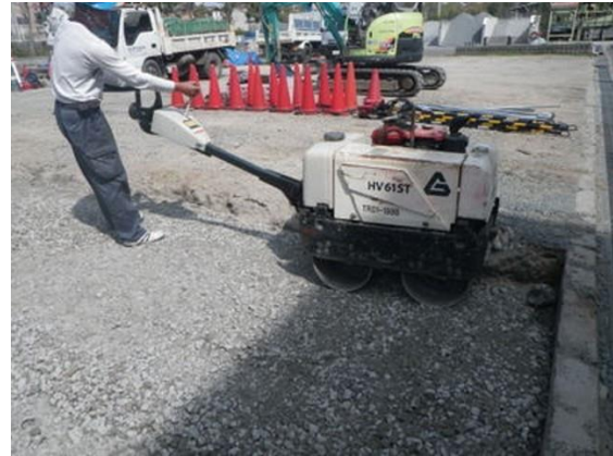
図 3-4-4 ハンドローラによる転圧
