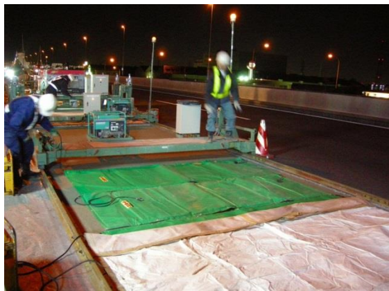
図 3-15-4 電熱シートによる給熱養生
