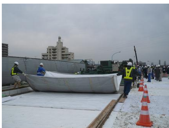
図 3-15-2 表面仕上げ後のシート養生
