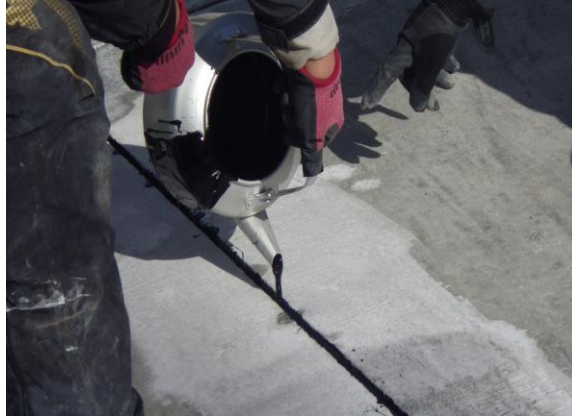
図 3-18-1 目地材の注入状況
