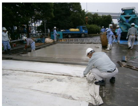
図 3-15-3 養生マットによる養生
