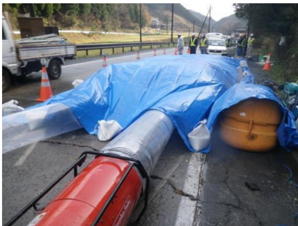
図 5-2-12 給熱養生の様子
