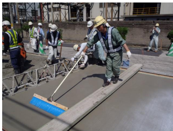
図 3-13-2 仕上げ状況
