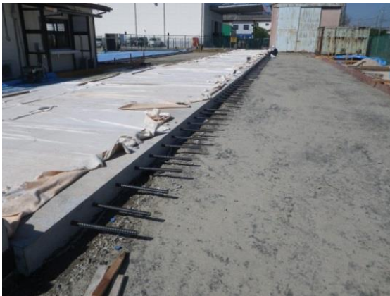
図 3-6-6 タイバーの設置
