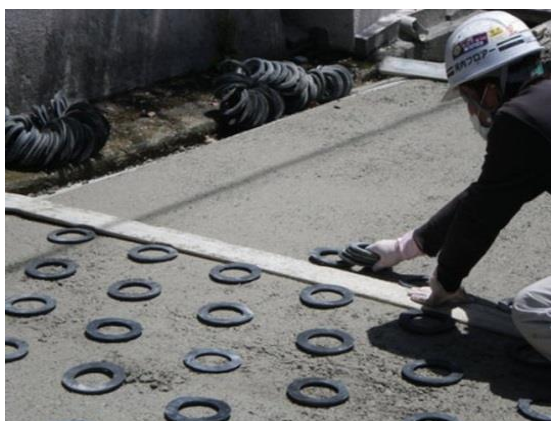
図 3-14-1 粗仕上げ後、リング設置
