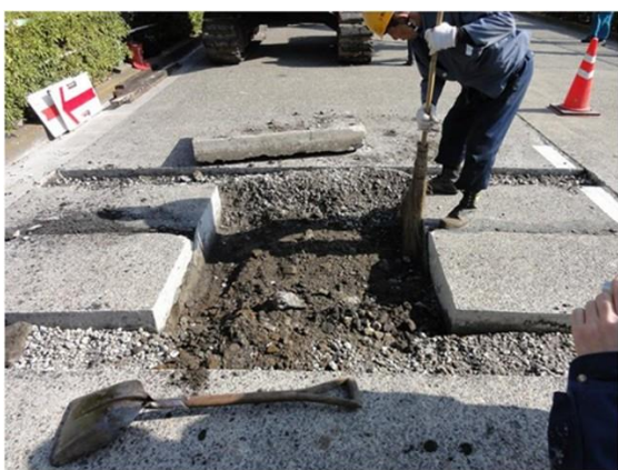
図 3-2-1 目地補修部のはつり作業
