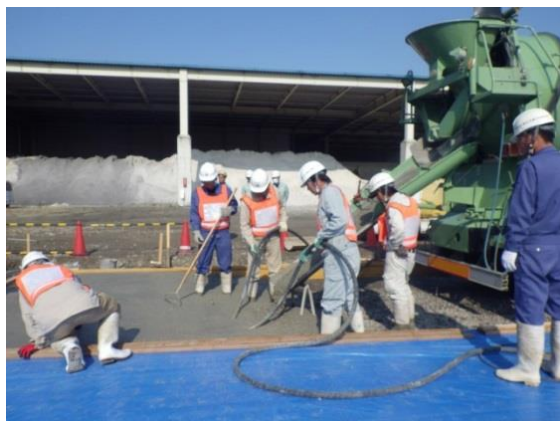
図 3-8-1 トラックアジテータからの直接荷卸し
