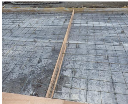
図 3-12-1 打込み目地の設置状況
