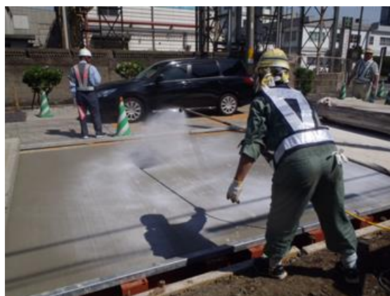
図 3-15-1 養生剤の散布状況
