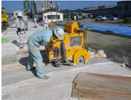
図 3-16-1 カッタ目地工の施工状況
