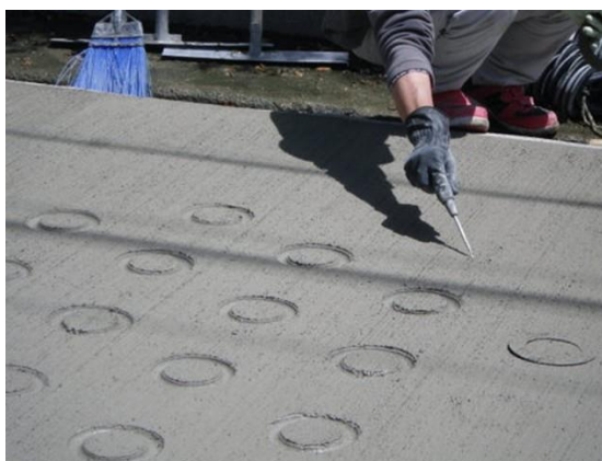
図 3-14-4 硬化前にリング除去
