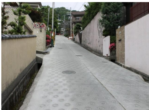
図 3-14-5 リング仕上げ完了
