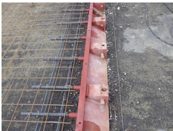
図 3-5-1 舗装用鋼製型枠
