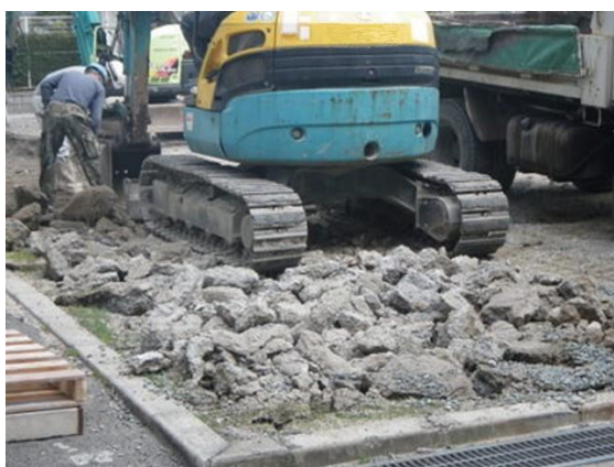
図 3-2-3 既設部はつり作業状況
