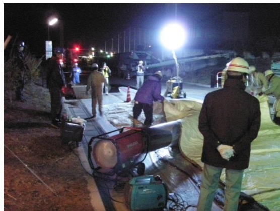
図 3-15-5 ジェットヒーターによる給熱養生
