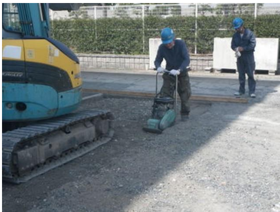
図 3-4-5 プレートによる転圧
