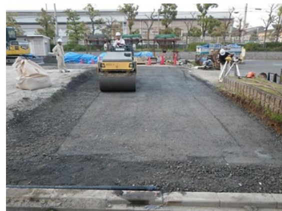
図 3-4-6 ロードローラによる転圧
