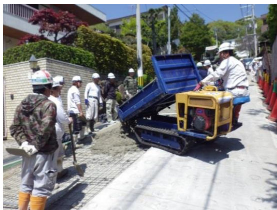
図 3-8-4 小型クローラ運搬車による荷卸し
