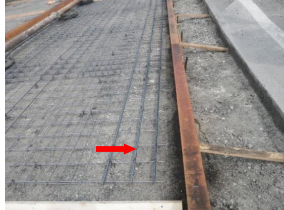
図 3-7-2 縦縁部補強筋の設置状況
