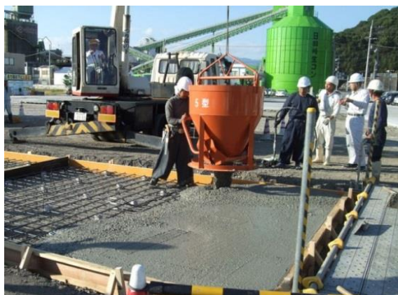
図 3-8-3 ホッパによる荷卸し
