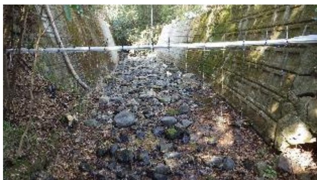
水路に設置したチェーン型電気柵 1
