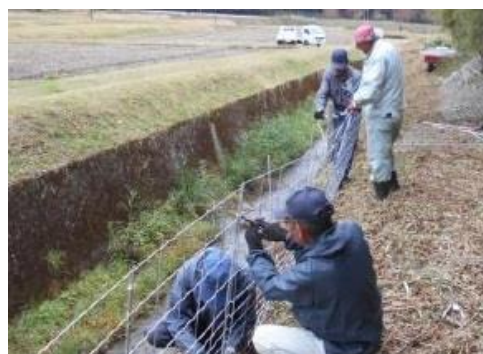
防護柵の設置作業 （山口市阿東 神角集落協定）
