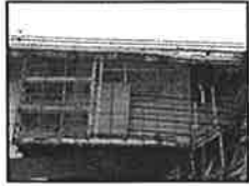
室津側桁端部足場
