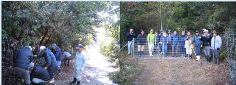
侵入防止柵（金網柵）の設置
