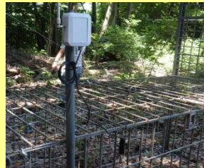
機器の設置状況
