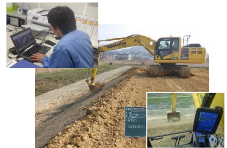
i-Construction の取組事例 (3次元データの活用とICT建機施工による作業の効率化)
