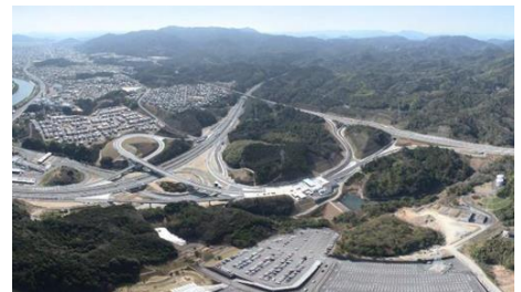
山口宇部道路小郡ジャンクション
