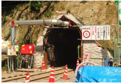
島田川工水トンネル工事（下松市）
