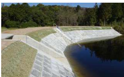
危険ため池の整備
