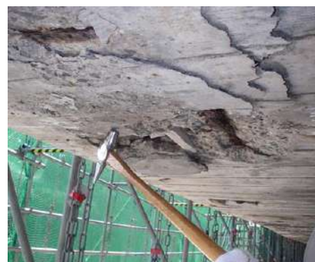
土木施設の老朽化対策 （橋梁床板の劣化状況調査）
