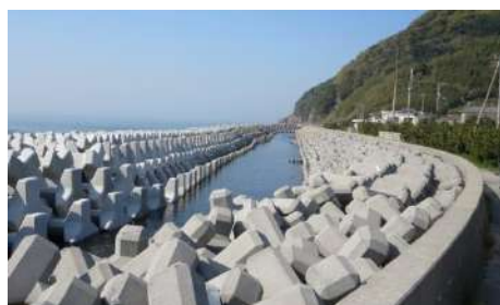
海岸保全施設
