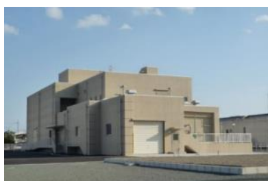
【長谷ポンプ場の整備】
