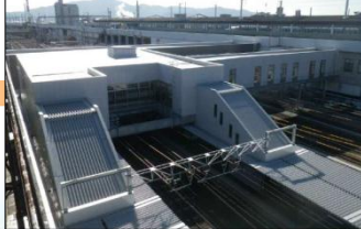
自由通路・橋上駅舎整備状況
