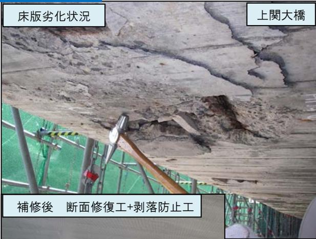
補修後 断面修復工+剥落防止工
