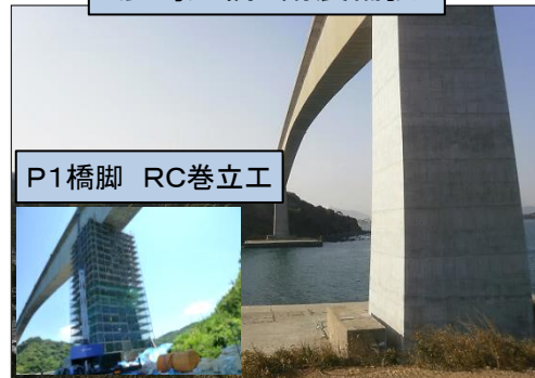
彦島大橋 耐震補強
