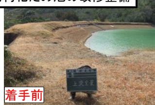
老朽化ため池の改修整備
