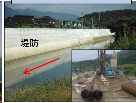
横曽根川 堤防の耐震化
