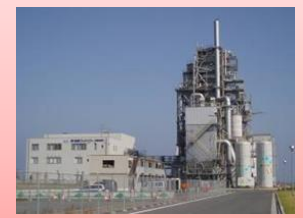
木質バイオマス発電所
