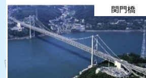
・開通: S48.11(47年経過) ・交通量: 39,219台/日 (R1)
