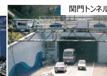
・開通: S33.3(63年経過) ・交通量: 26,974台/日 (R1)
