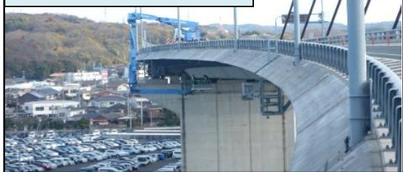
栄川運河橋 橋梁点検状況
