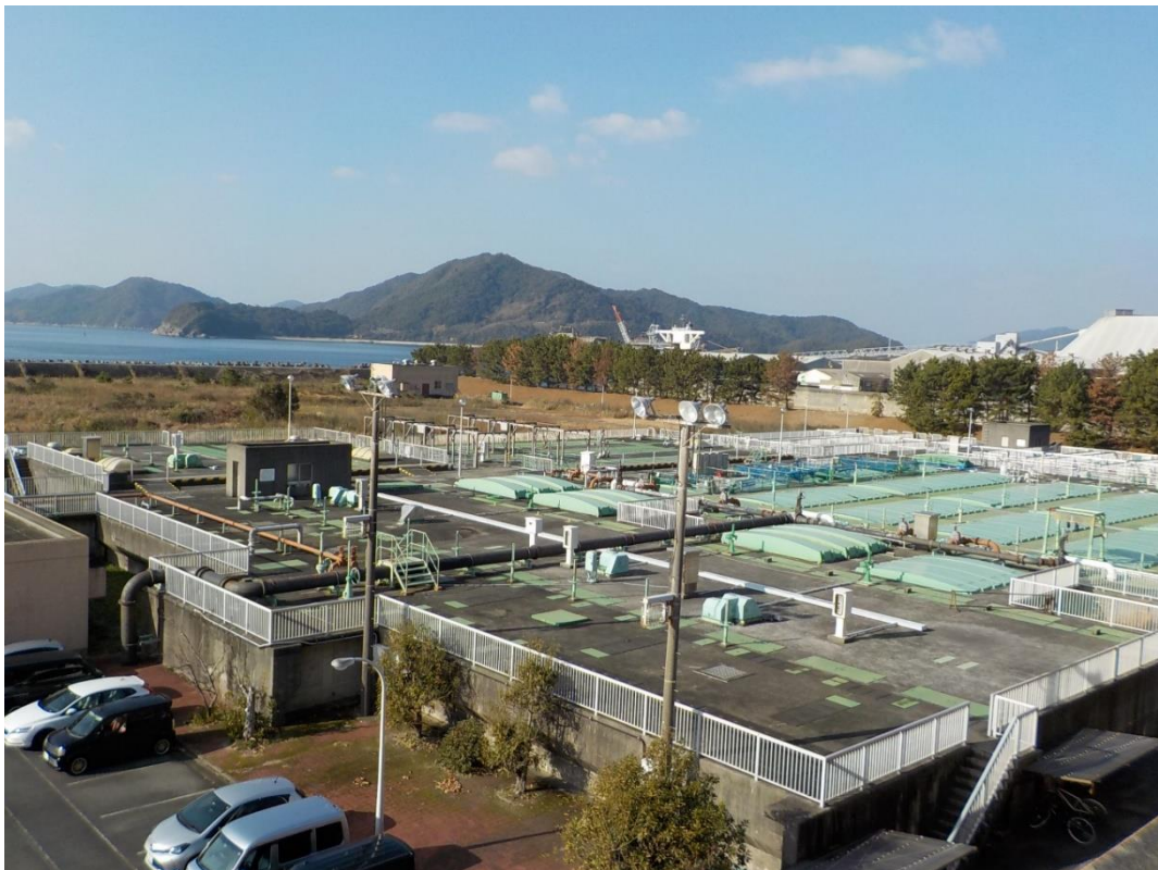
周南浄化センター全景
