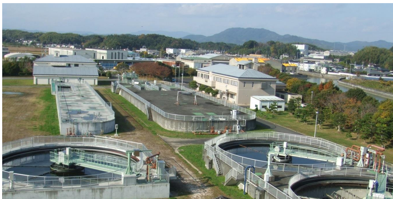
田布施川浄化センター全景
