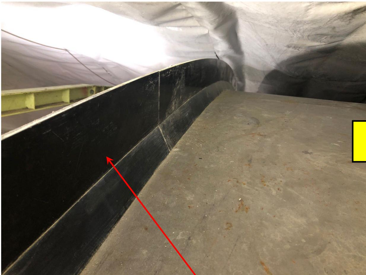
妻型枠の一部に鉄板を設置
