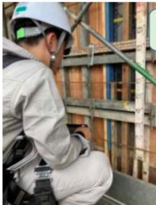
元請① 透明型枠前で、高さを確認
