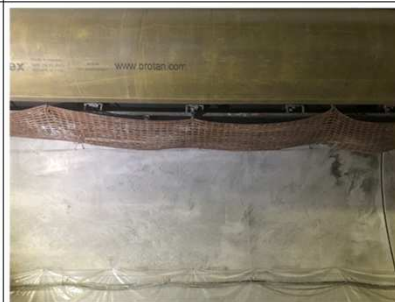
左側壁部（裏側）
