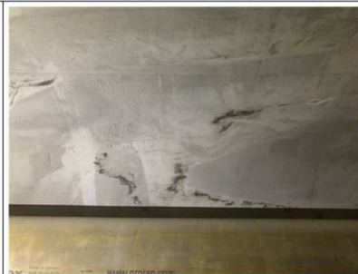
左肩・天端（裏側）
