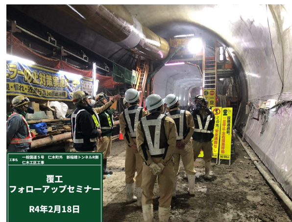
覆工セミナー（打設後現場確認）
