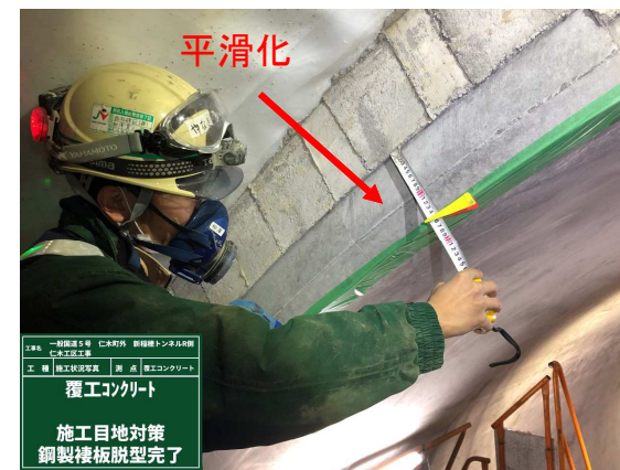
施工目地脱型後状況
