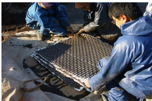
土のう式マット法の播種前処理状況
