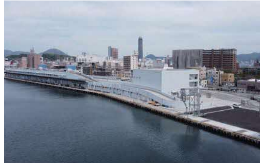
高度衛生管理型荷さばき所(下関漁港)
