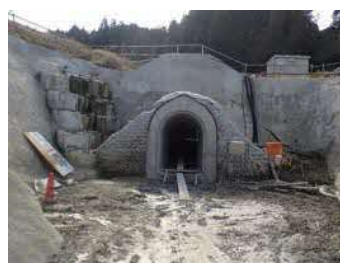
木屋川工水 二条化送水路トンネル工事
