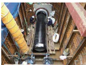
厚東川第2期工水 バイパス管工事
