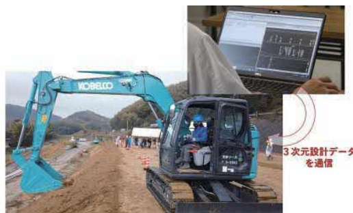
3次元データの活用とICT 建機施工による作業の効率化
