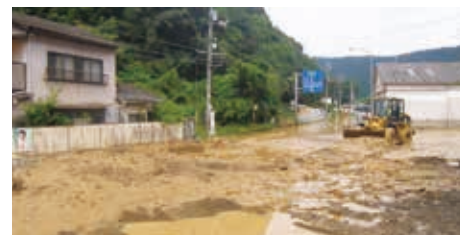
[災害復旧現場での作業]
