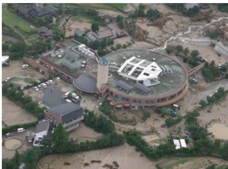
防府市真尾 土石流被害
