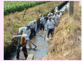
水路の泥上げ
