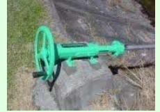
ゲート、バルブの更新
