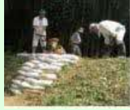
漏水箇所の補修
