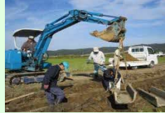
コンクリート水路の更新
