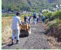
未舗装農道の舗装
