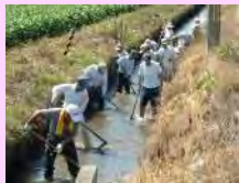
水路の泥上げ
