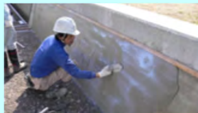
老朽化した水路壁のコーティング
