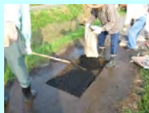
農道の部分補修
