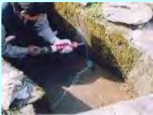
水路のひび割れ補修
