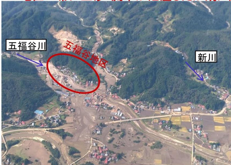
丸森町の被災状況(主に五福谷川周辺)
