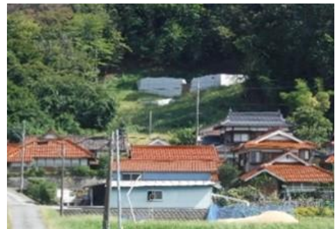
治山ダムの整備
