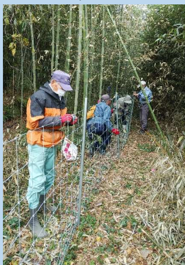
【防護柵設置状況】
