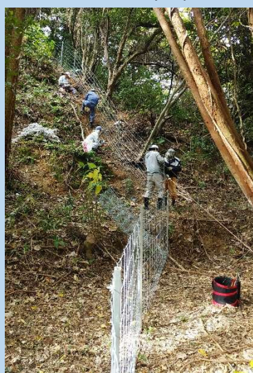
【急傾斜地での作業状況】
