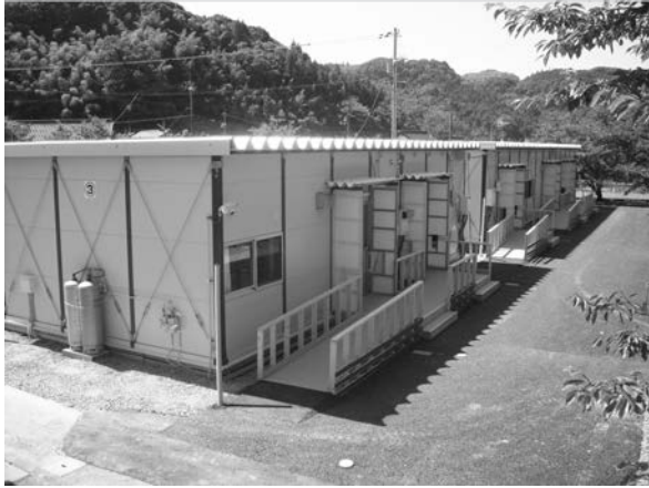
写真－1 「山口県大雨災害」時に建設した応急仮設住宅
