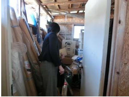
改善前の倉庫内
