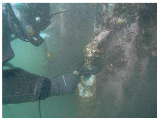
図 3.5.8 陽極電流測定状況例
