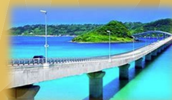
角島大橋（下関市）
