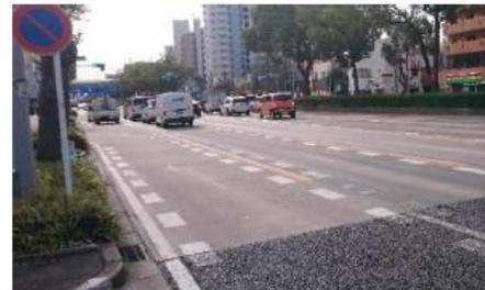
・大型車混入率が高い箇所や交差点部などは、As舗装に比べわたち掘れ・骨材飛散が生じにくいCo舗装の強みを活かすことができる。
