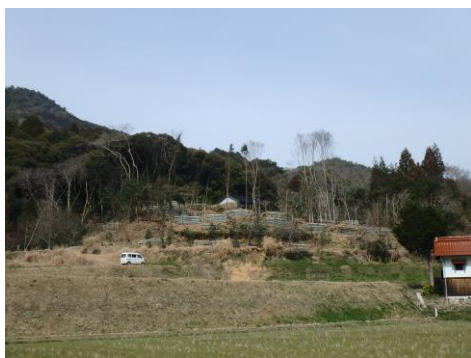
R4 繁茂竹林整備事業 竹林伐採事業地（山口市）
