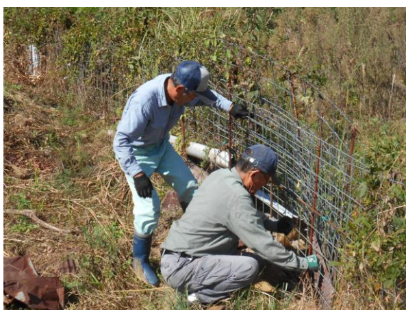
防護柵の点検・補修作業 （山口市 神角集落協定）
