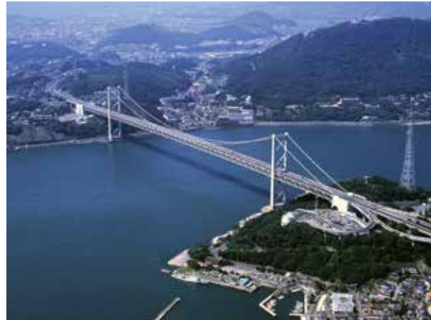
■関門橋の通行止め状況 (H30～R4年度)
