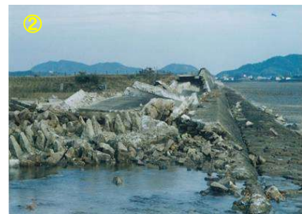
※山口地区(南前)堤防倒壊による浸水状況(H11.9.24)
