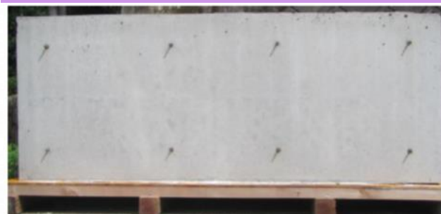
コールドジョイントや充填不良なく良好な仕上がり
