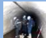
作業員による調査
