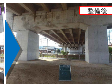
鉄筋コンクリート巻立て工法
