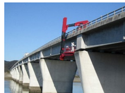
橋梁作業車を使った点検状況
