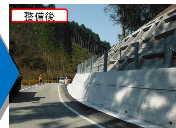
のり砕工+落石防護柵工
