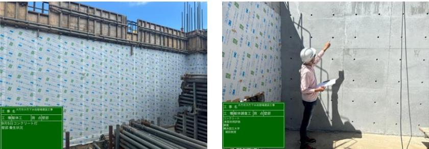
貼付けタイプのため表面が見えず、現状ひび割れ調査はできません。脱型直後に確認したところひび割れは発生していませんでした。
