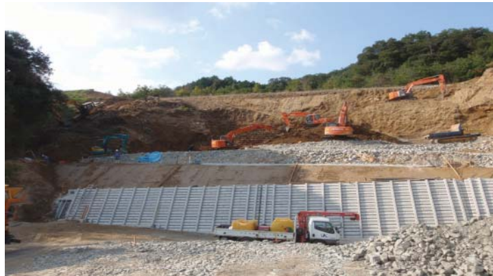
国道435号復旧工事の状況
