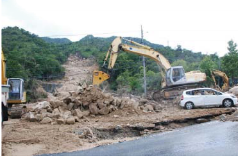
防府市勝坂での重機による崩土の撤去作業
