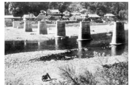
流失した天尾橋
