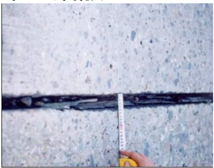
目地材のはみ出し・飛散
