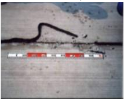
目地材のはみ出し・飛散
