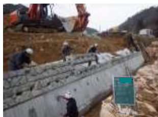
(使用機械、据付方法)
