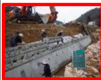
(使用機械、据付方法)
