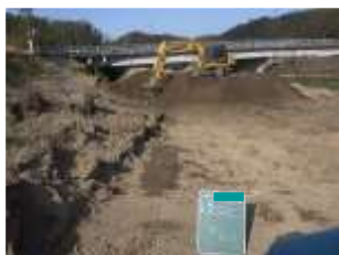
（使用機械、掘削方法）
