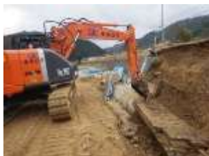
(使用機械、取壊し方法)
