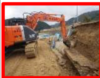
(使用機械、取壊し方法)
