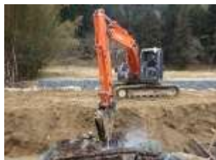
(使用機械、取壊し方法)
