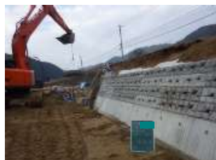
(使用機械、据付方法)
