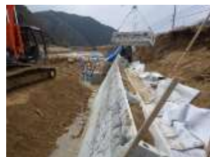
(使用機械、据付方法)
