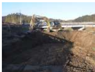
（使用機械、掘削方法）
