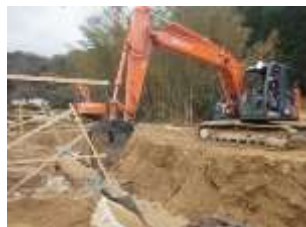
(使用機械、取壊し方法)
