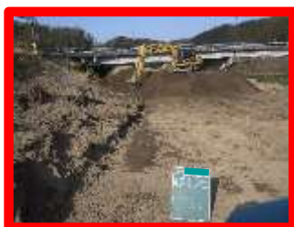
（使用機械、掘削方法）
