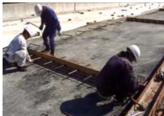
横目地の施工
