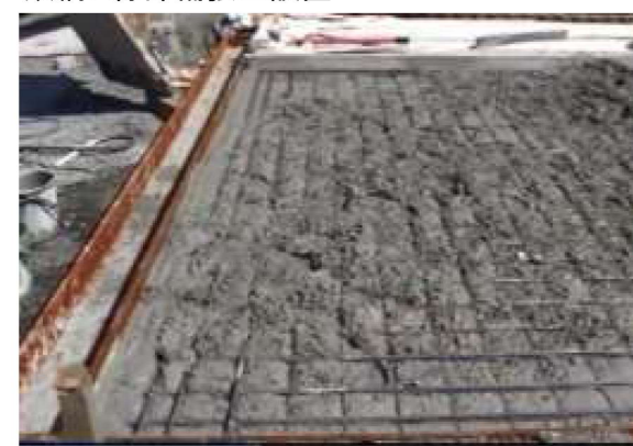
鉄網と縁部補強金設置
