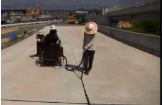
目地(注入・縦目地)
