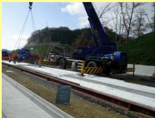
舗装機械据換え状況(セットフォーム)
