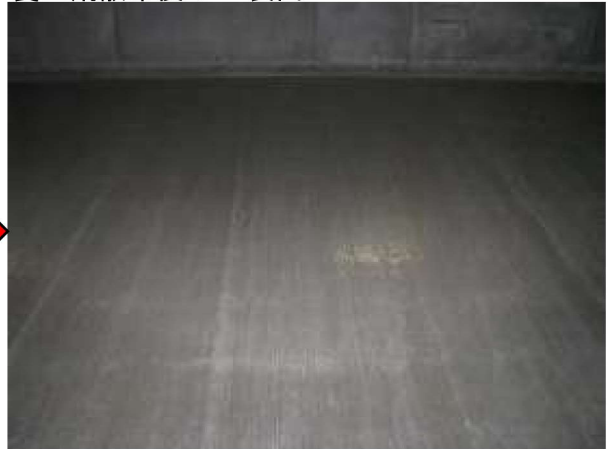
養生剤散布後のCo表面
