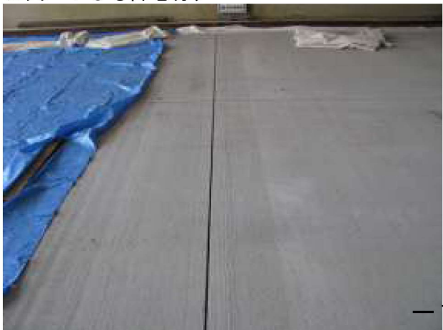
カッターによる目地切り
