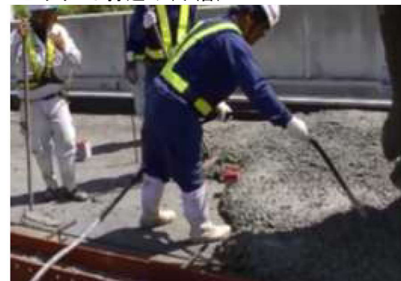
コンクリート打込み(下層)
