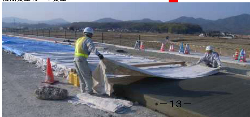
後期養生(シート養生)
