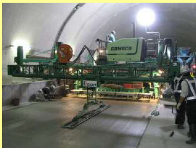
レベラ部(平たん仕上げ作業)
