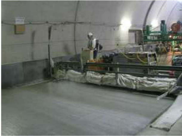
仕上がり状況
