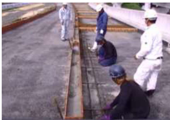
型枠設置と縦目地の施工
