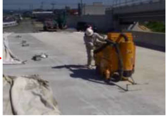
目地(カッター・縦目地)
