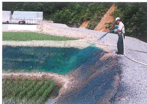
畦畔方面への牧草種子吹付け作業
